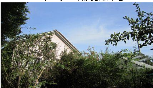
屋根の上にはソーラーパネル
