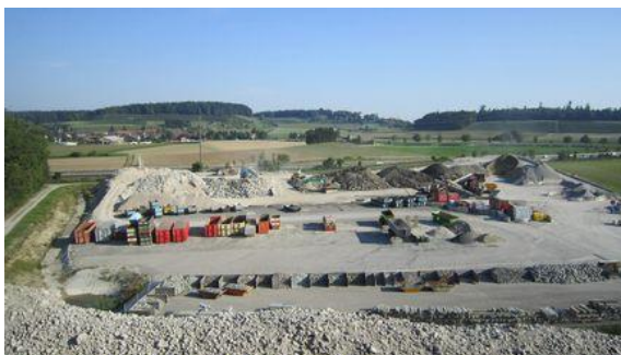
建築廃棄物は細かく分別されている
