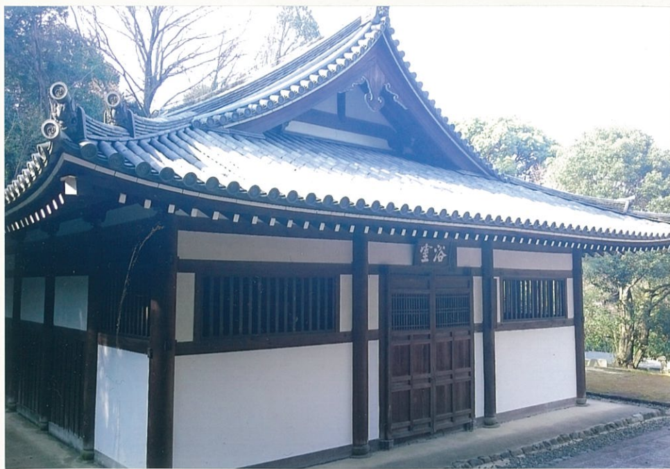
浴室 (重要文化財)
